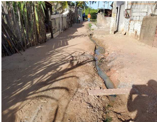
Figura 9: Área em que ocorrem alagamentos em Barreiras, Poço.
