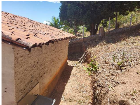
Figura 7: Corte baixo em trecho de encosta pouco inclinada. Miraí de Baixo.
