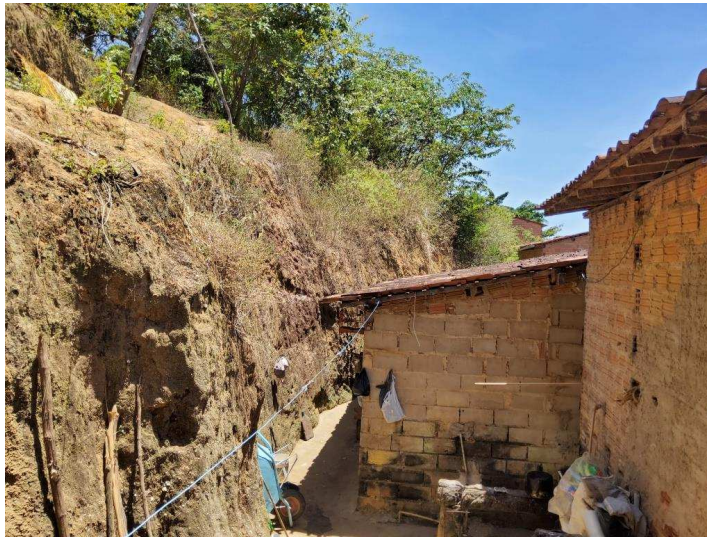
Figura 3: Talude de corte próximo a residência. Setor 004. Bairro Vassouras.
